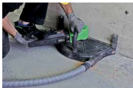
lavoro vicino ai bordi con il kit di accessori + il disco da taglio diamantato (accessorio)
