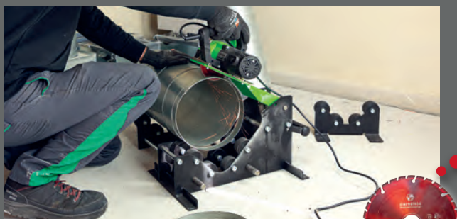
Grande risparmio di tempo nel taglio delle canaline di ventilazione
