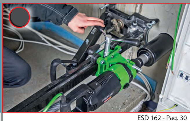
Carotaggio in materiali duri
