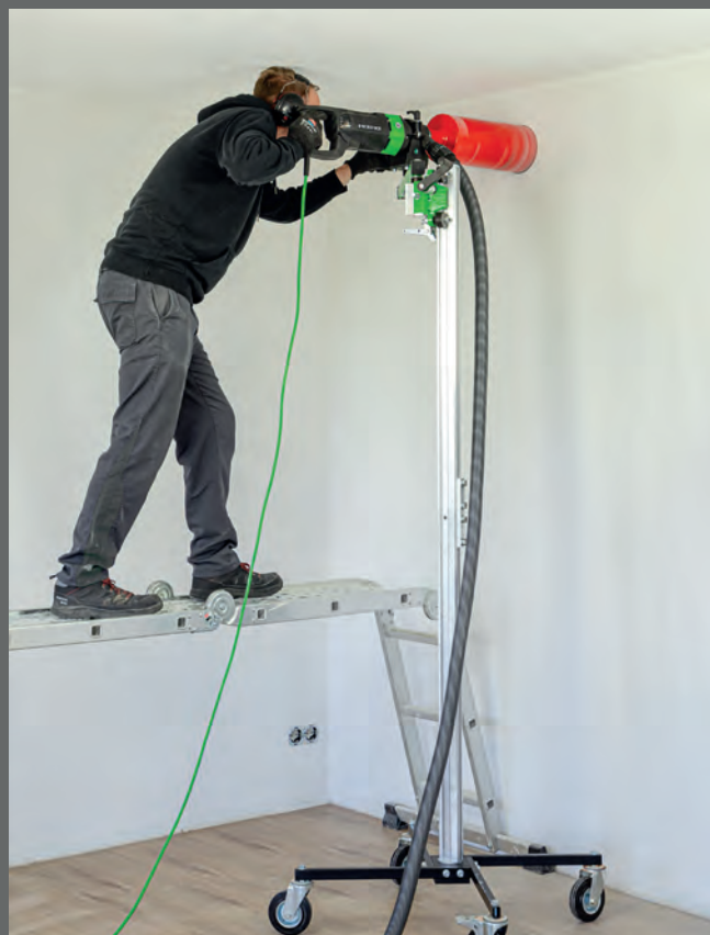
Fori di ventilazione fino a 2,30 m di altezza con estensione della colonna
