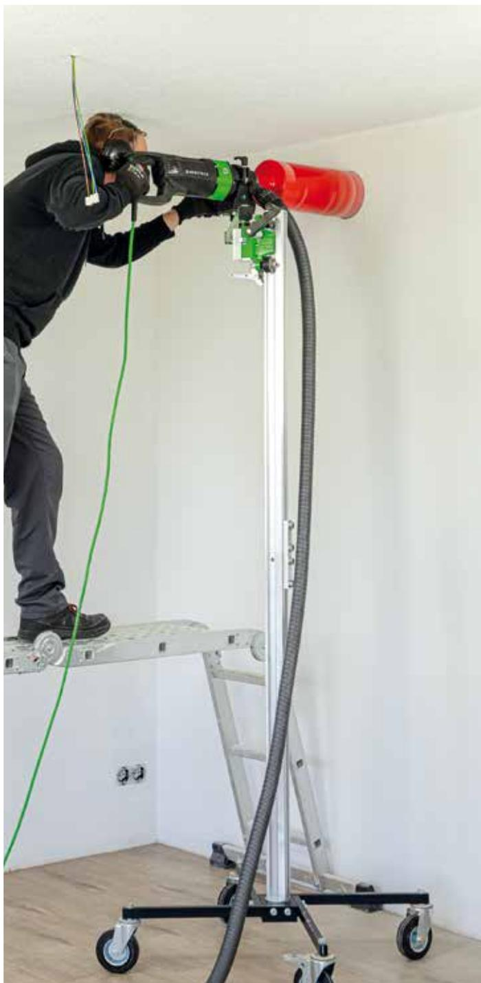
Fori di ventilazione fino a 2,30 m di altezza con braccio estensione colonna (accessori)
